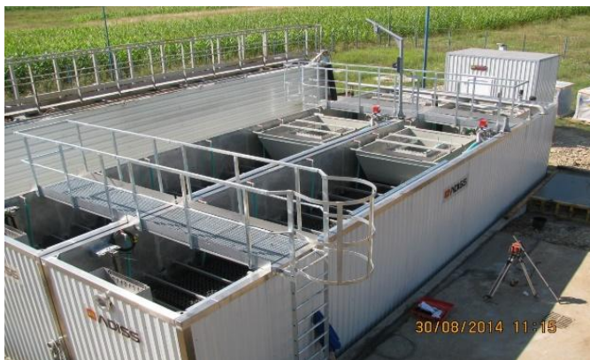
Fig. 6. SEAU Bradu - instalare module de epurare
