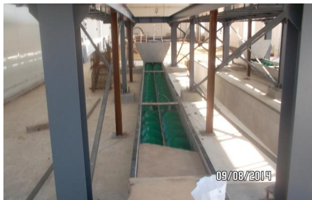
Fig. 7. SEAU Pitești – montaj echipamente hală filtre
